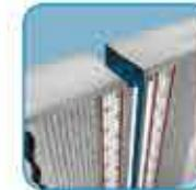
Konstrukcijske dilatacije dugih građevina trebaju se prenijeti na fasadni sustav pomoću okomitih **dilatacijskih profila**.
